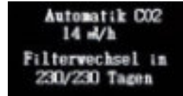
Anzeige der Lüftungsstufe, Volumenstrom und Filterrestlaufzeit
