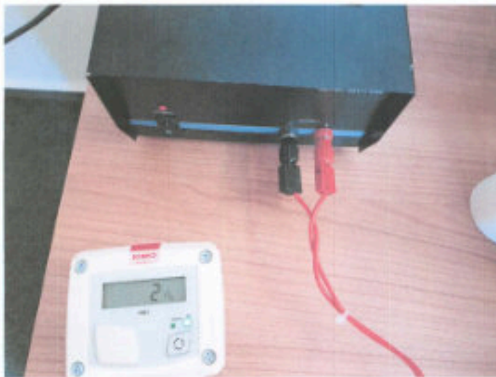
9:49 Uhr Streambox mit Förderleistung von 50 m 3 pro Stunde Zuluftöffnung abgedichtet Differenzdruck 2 Pa
