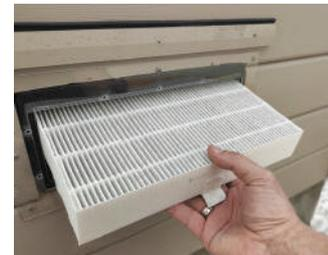
Zum Wechsel des Außenluftfilters entfernen Sie den Wetterschutzdeckel an der Außenwand. Ziehen Sie den Filter an der Lasche nach draußen und heben Sie nun die Filter aus dem Filterrahmen. Reinigen Sie die Filter oder tauschen Sie beide Filter gegebenenfalls aus.
