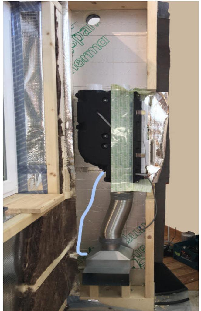
Der Kondensatablauf (hellblau) wird entweder durch die Außenwand geführt oder, besser, am Abwassernetz des Hauses angeschlossen. Dabei wird nicht unbedingt ein Siphon benötigt, da das Kondensat im Abluftstrang anfällt und daher nicht mit Geruchsbelästigung zu rechnen ist.
