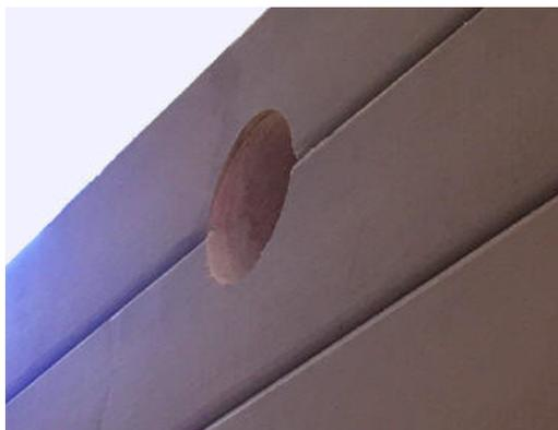
Die Ausschnitte sollten wasserdicht versiegelt werden. Bei Holzwänden müssen die Ausschnitte somit grundiert und gestrichen werden (2x), bei Steinwänden aus Yton oder Kalksandstein sollten die Ausschnitte mit einer wassersperrenden Beschichtung versehen werden.
