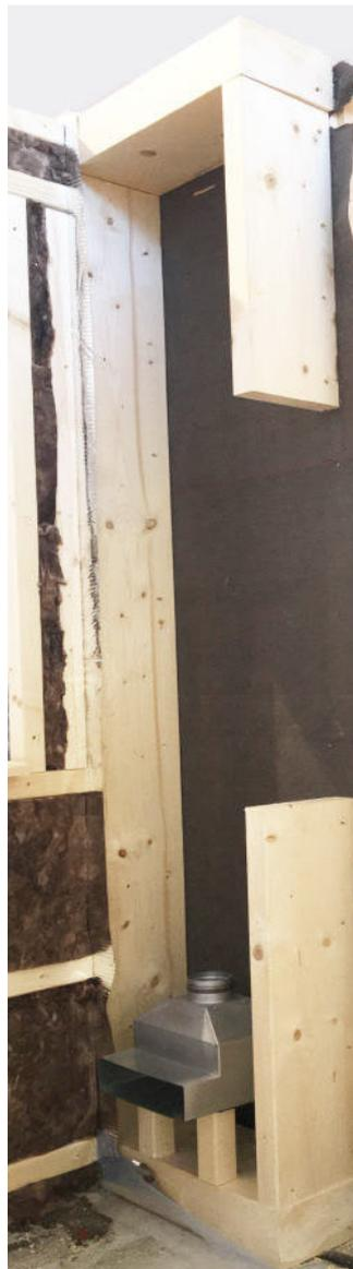
Setzen Sie nun die StreamBox am Federstahlbügel zwischen den beiden oberen Düsenauslässen an der Wand mit einer 20ger Tellerkopfschraube an.
