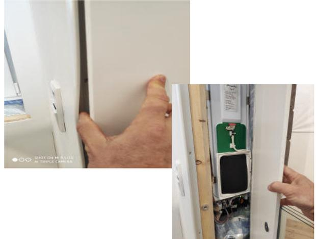
Die Entnahme des Abluftfilters ist ganz einfach: Öffnen Sie die Leibungsklappe in der Fensterleibung und ziehen Sie den Schaumstofffilter einfach aus dem Filterrahmen, reinigen oder wechseln ihn und setzen ihn nach dem Trocknen wieder ein. Danach lassen Sie die Leibung einfach wieder in die Magnethalter „klacken“.
