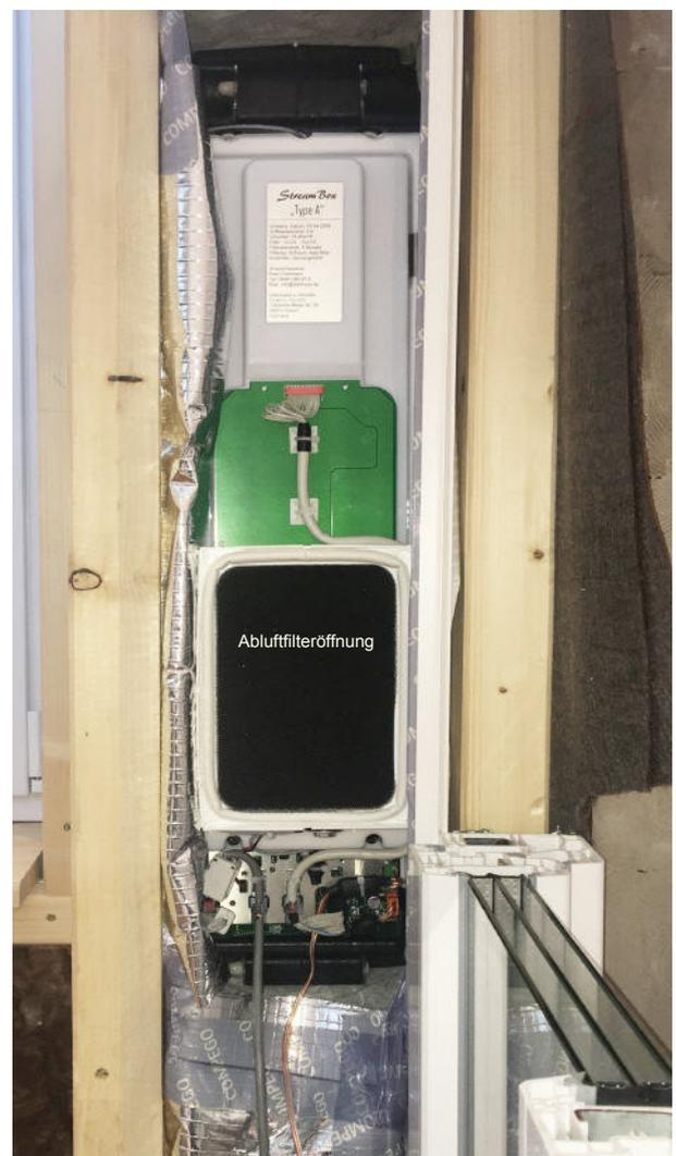
Nach der Verlegung des Stromversorgungs-Kabels können Sie die Wand verkleiden. Zuerst passen Sie die OSB-Platte an. Dazu messen sie sich bitte die Maße und Positionen der Weitwurfdüse und des Revisionschachtes der Filterbox aus und übertragen sie die Positionen und Maße auf die OSB-Platte.
