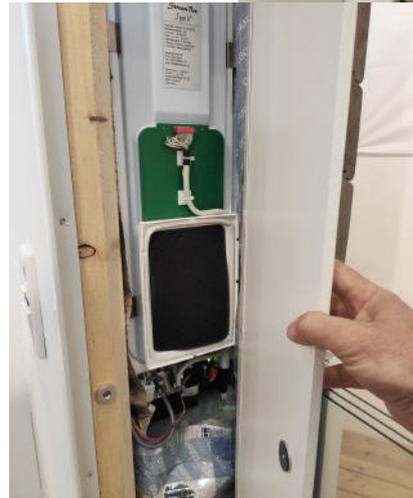
Die Laibungsplatte kann dann in der Scharnierleiste der Laibung geöffnet werden. Um Gerät zu öffnen (z.B. um ins Innere zu gelangen um Ventilatoren zu reinigen oder zu wechseln oder um den Wärmeübertrager zu entnehmen zur Reinigung) kann die gesamte Laibungsplatte mit Scharnierleiste abgezogen werden.
