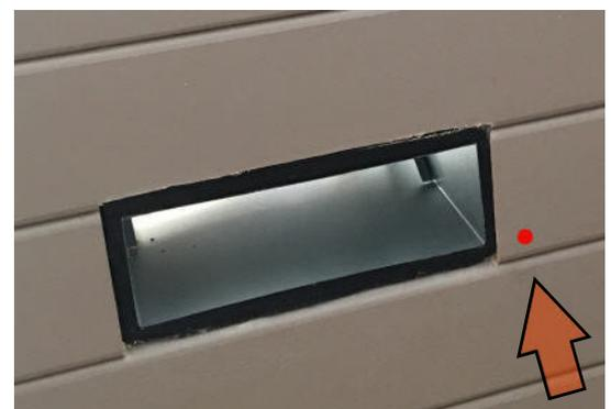
Setzen Sie den langen Spiralbohrer am roten Punkt außen so an, dass er mit einer Steigung von min. 30° nach oben durch die Blockbohle verläuft. So, dass das Kondensat zügig nach Aussen ablaufen kann.
